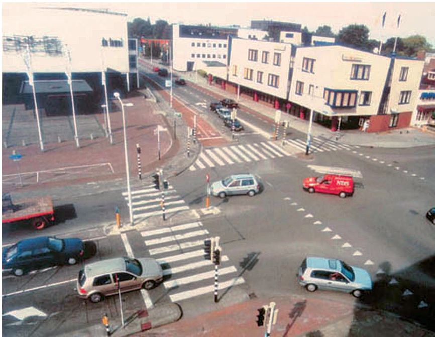
⇨ The "Laweiplein", por by Hans Monderman. Drachten, Países Bajos The Netherlands. Las señales de tráfico son reemplazadas por el "squareabout". Traffic signals replaced by a "squareabout".
